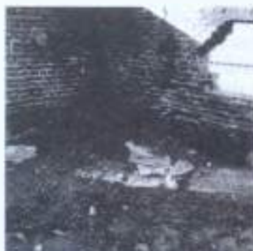
▲ Basura entre los muros lisaboeos: nótese las marcas que el fuego dejó en el union, el carbon en el piso y la acumulación de casi un metro de escombros.
