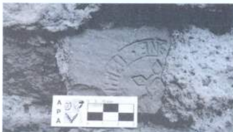
▲ Detalle del fragmento de baldosa francesa incluido en una de las paredes.
